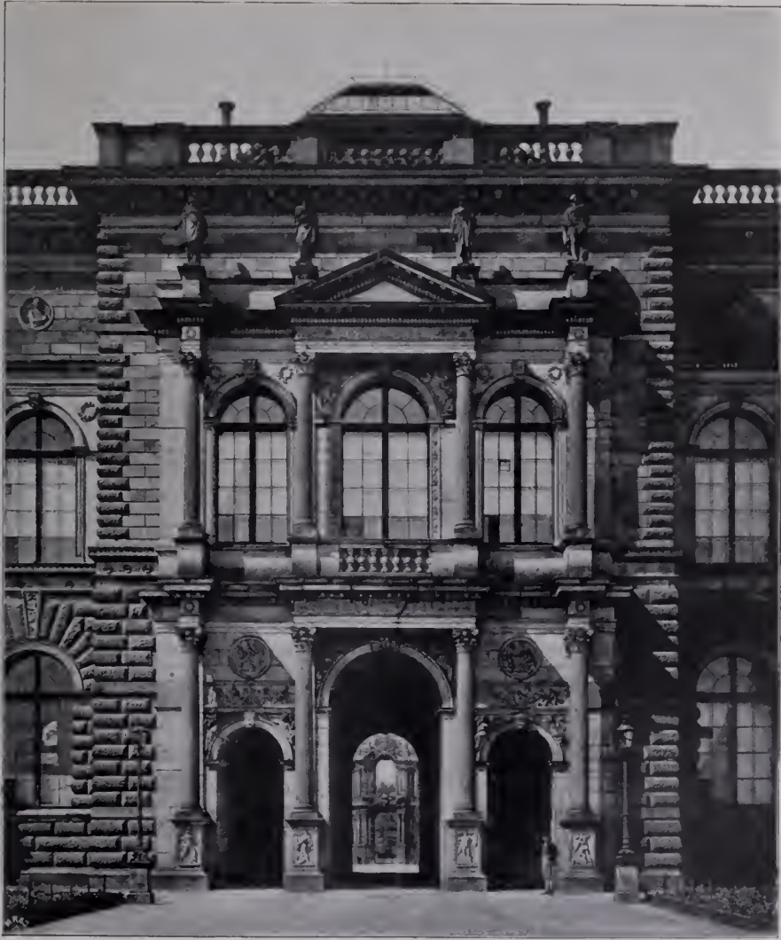
GOTTFRIED SEMPER: NORDEINGANG DER DRESDNER GALERIE
